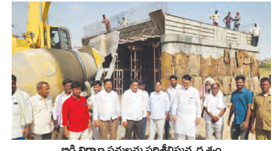
బిడ్డి నిర్మాణ పనులు పరిశీలిస్తున్న ద్మక్షం
